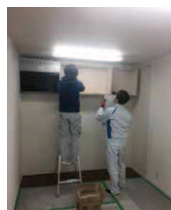
システムキッチンの取付け
