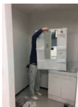
洗面化粧台の取付け
