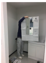
洗面化粧台の取付け
