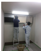
システムキッチンの取付け
