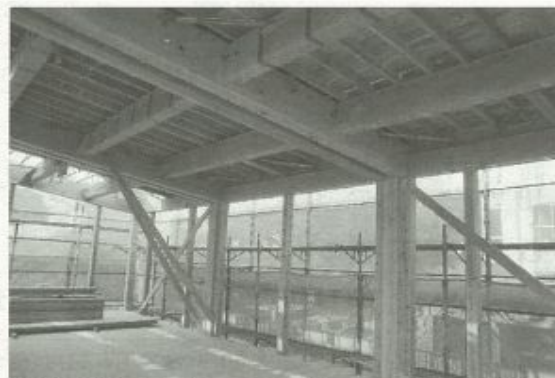
球磨産杉KDのほり梁は現して使用した
