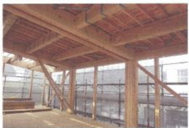
球磨杉KKD平角を現し工法で使用した
