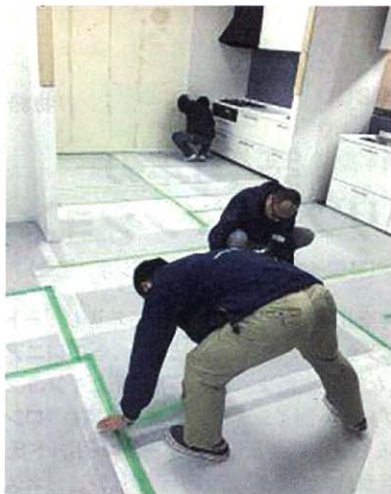
▲養生は毎日剥がして、張り直す
