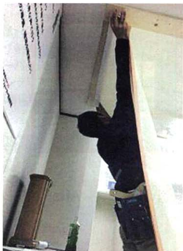
▲天井もクロス張りの練習に活用
